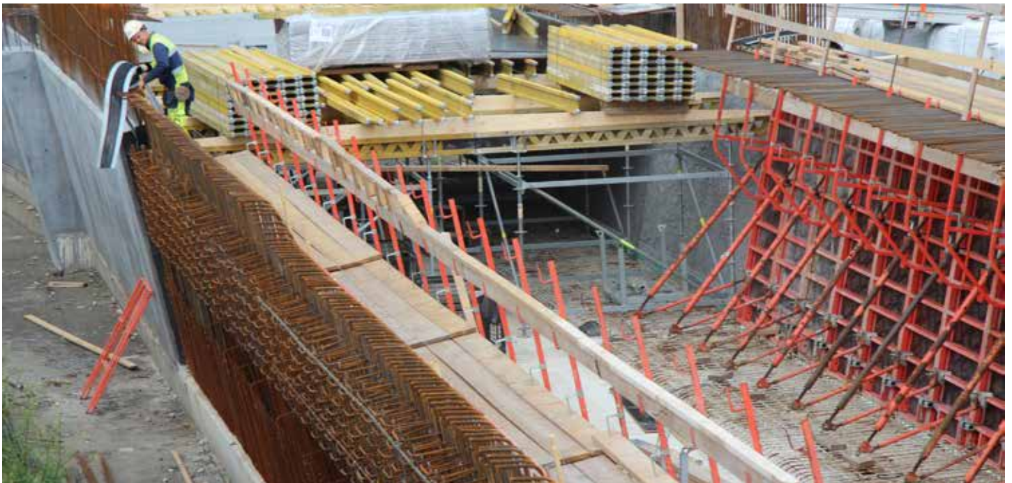
Werkzaamheden aan de fietsonderdoorgang gaan door.
