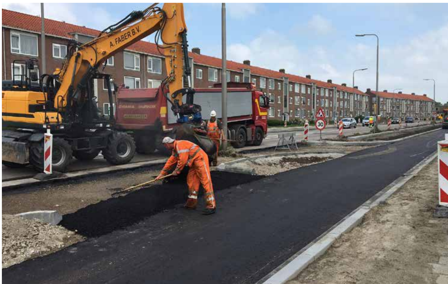
Op de parallelweg wordt een laag asfalt aangebracht.
