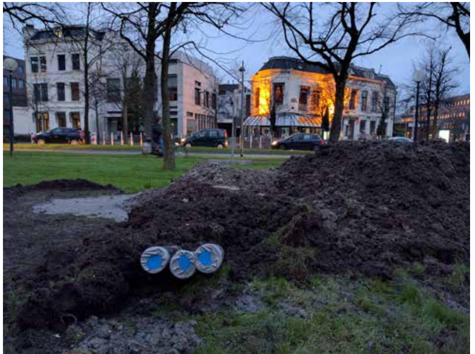
Door een boring onder de straat door, kon het verkeer doorrijden.
